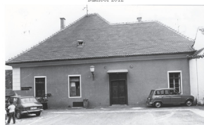
Trg ob sinagogi v središčni ulici, stanje pred požarom obsojenih del (Arhiv Sinagoga Maribor, Dokumentacija ZVIKD Maribor)
