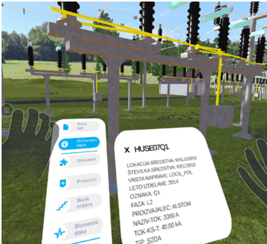
Slika 2: Ponazoritev uporabnosti povezave tehničnega informacijskega sistema in virtualnega okolja s prikazom tehničnih podatkov posameznega elementa v virtualnem stikališču. (Vir: Projekt DigiELES, 2022)
