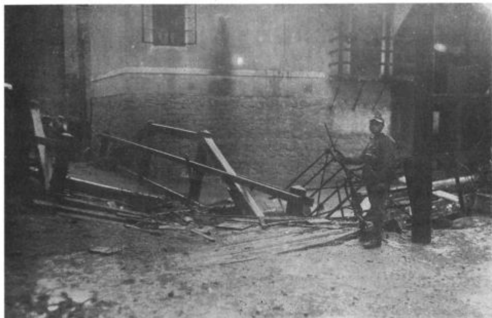
Vojak straži hudo poškodovani most pri »Bašeriji« septembra 1926
