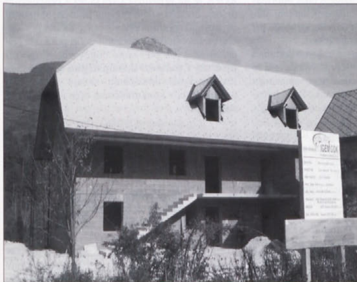
Pri obnovi stavb so se Korošci zelo izkazali
