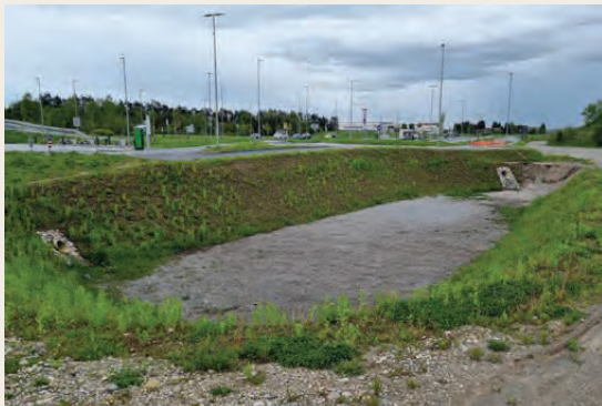
Južna infiltracijska kotanja - prazna v pomladnem času in polna ob obilnem deževju. Foto: Kristina Klemen
