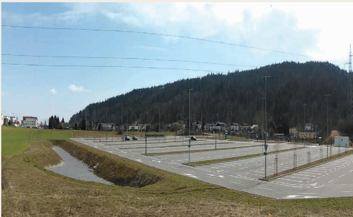
Severna infiltracijska kotanja ob P+R Stanežiče. Foto: Matej Radinja
