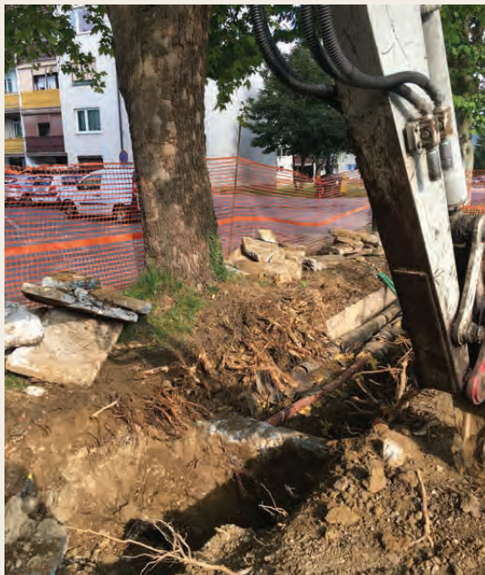
Prenova vročevoda leta 2020. Koreninski sistem je bil med deli prekrit, zato so ga morali po gradbenih posegih drastično obrezati, da so ohranili stabilnost in varnost. Foto: Tanja Štadjohar
