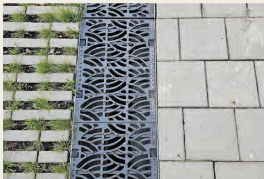
Povečanje infiltracije padavinske vode z zamenjavo neprepustnih površin s prepustnimi. Foto: Maja Simoneti
