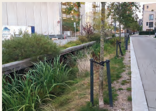
Jarek z vlagoljubnimi rastlinami s funkcijo zadrževanja in počasnega odvajanja padavinske vode. Foto: Matej Radinja
