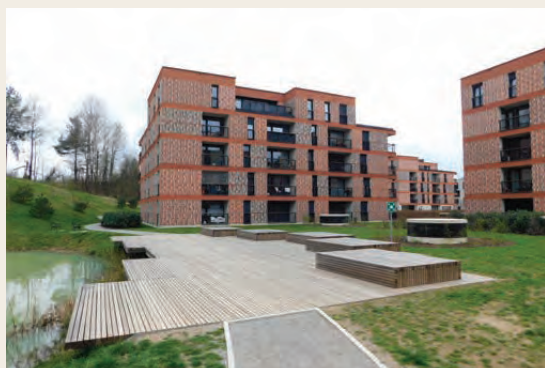
Podest ob zadrževalniku. Foto: Goran Jakovac
