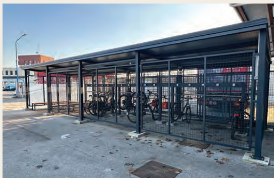
Lokacija pri vhodu v podjetje po izgradnji pokrite kolesarnice. Foto: Miha Štucin
