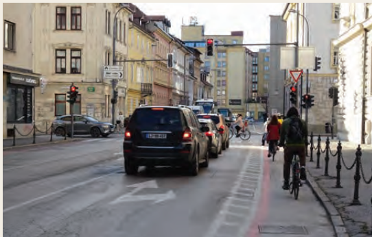
Ukinitev desnega zavijalnega pasu na Komenskega ulici je omogočila umestitev kolesarskih pasov v širini okoli 1,2 m z varnostnim odmikom in s tem bistveno izboljšano varnost kolesarjev. Foto: Marko Peterlin
