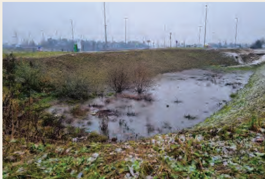
Južna infiltracijska kotanja - prazna v pomladnem času in polna ob obilnem deževju. Foto: Kristina Klemen
