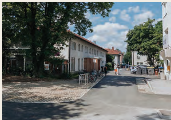
Vzpostavitev območja s prepustnim tlakovanjem. Foto: Amadeja Smrekar
