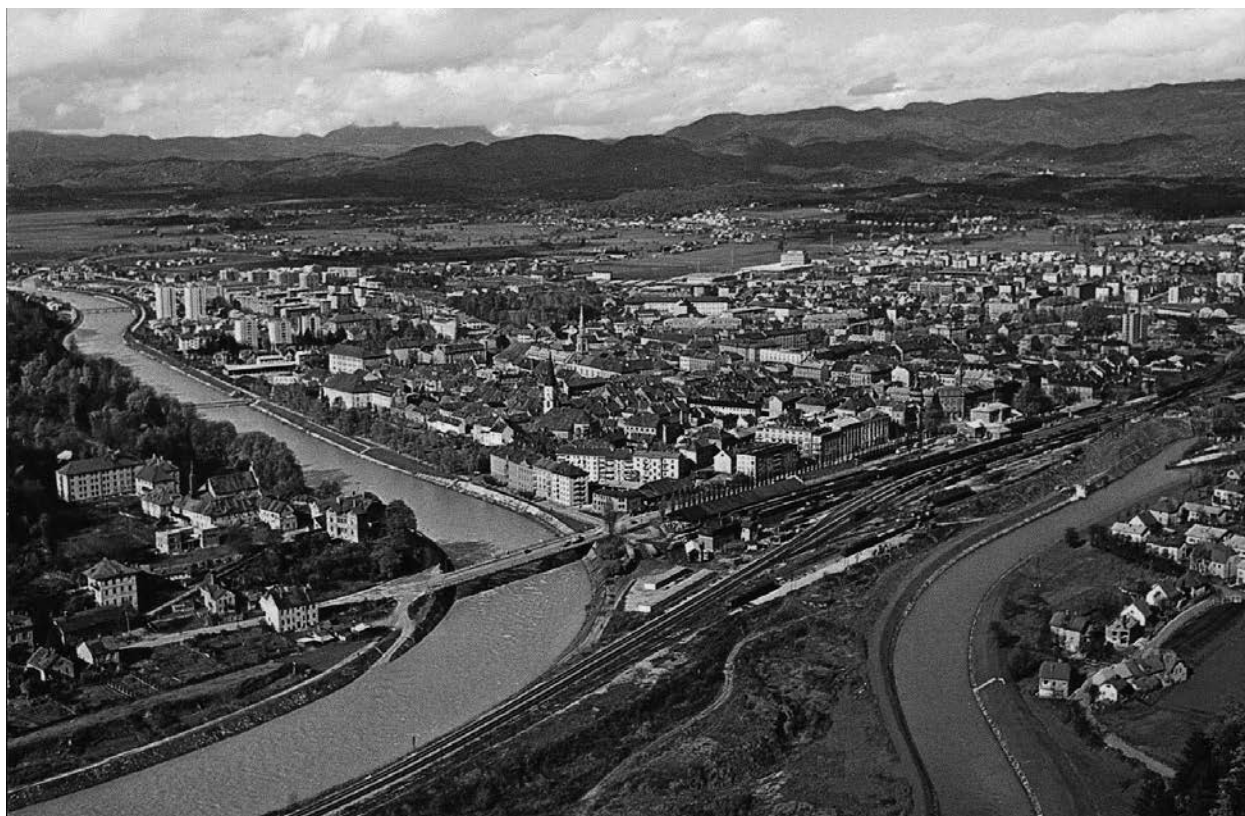
Del stare struge Vogljajne (skrajno desno) pred njenim zasutjem, 1967 (Vir: SI_ZAC/1274/002/015/00002_00028 Zbirka razglednic in fotografij)
