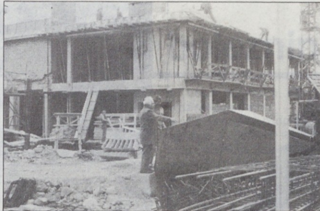
Gradbena dela za razširitev pekarnice Center hitro napredujejo ...
