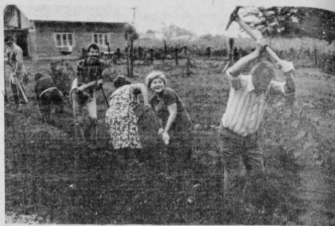
Krajsani Dornave na sobotni delovni akciji pri izkopu jarka za sekundarni vodovod v njihovem kraju. (foto: M. Ozmeč)
