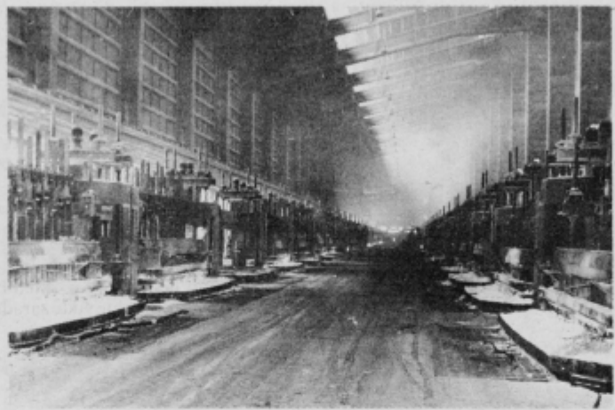
Del elektrolize hale B v TGA Kidričevu, kjer je proizvodni proces že precej zastarel in tudi delovni pogoji so težki.
