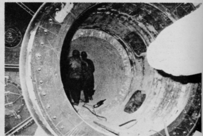
Remont rotacijske peči — zamenjava dotrajane šamotne opeke v posebnih rotacijskih pečeh, kjer pri visokih temperaturah žgejo boksit in glinice. Posnetek: M. Ozmec
