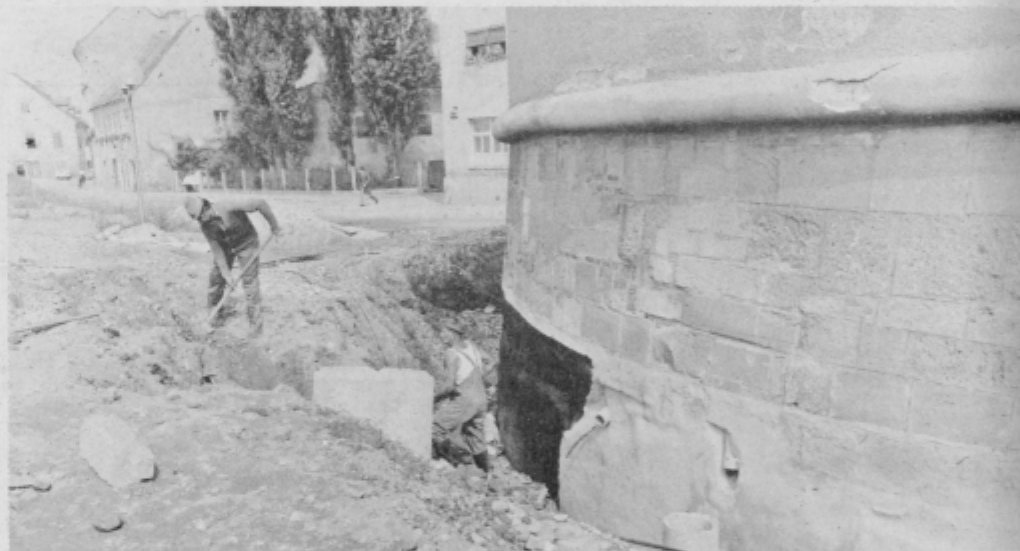
Zaščitna dela pri objektu razstavnega paviljona v mestnem parku ob Dravi
