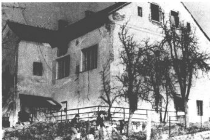
Stara šola je objekt v zelo slabem stanju
