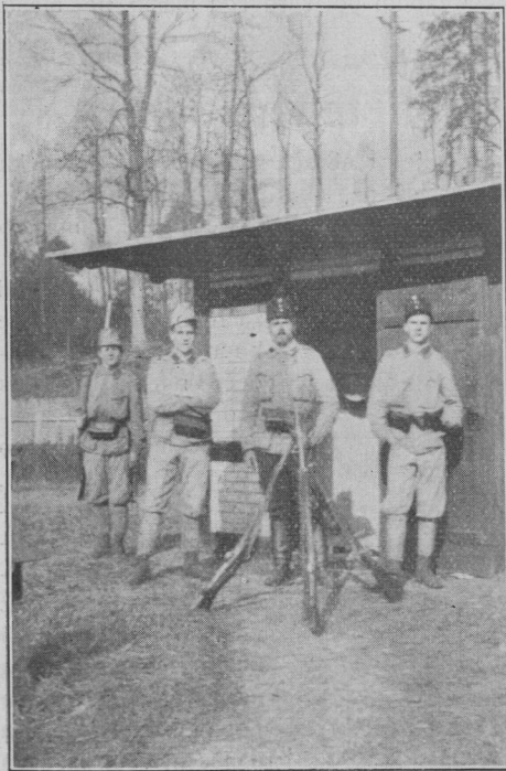
Straža ljubljanskega vodovoda.
