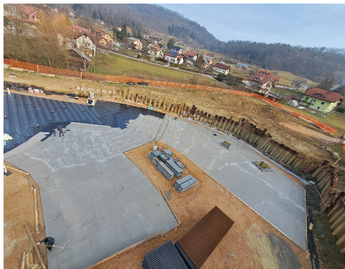
Slika 3. Polaganje hidroizolacije na temeljno ploščo.
