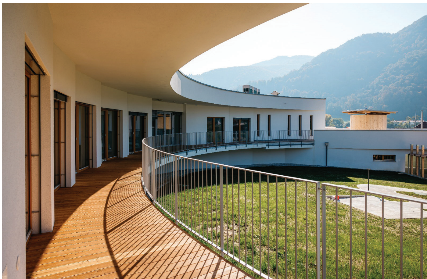
Slika 8. Značilna etaža objekta s skupno teraso.
