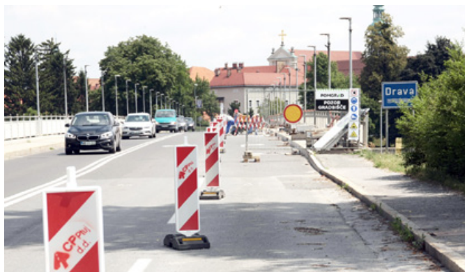
Rok za dokončanje del na mostu je 30. 9. 2018.
