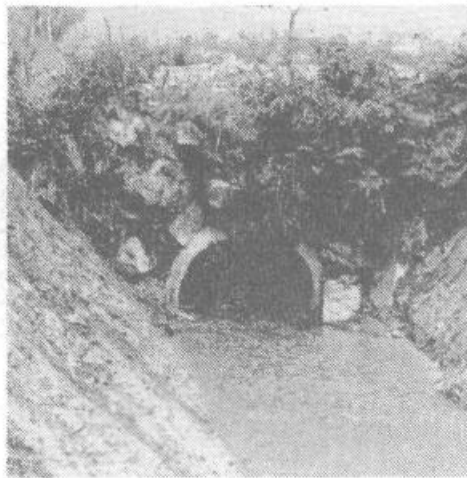
Trden most kot skala, kost, toda pretok premajhen
