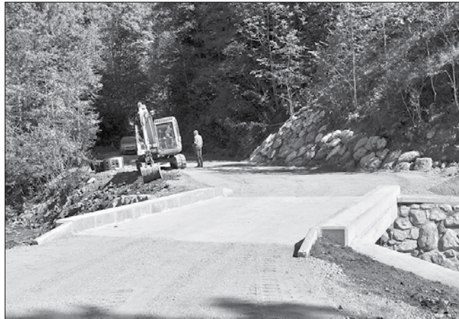
Ob mostu in na cesti pri Kočnarjevi žagi potekajo še nekatera manjša ureditvena dela. (Foto: LM)
