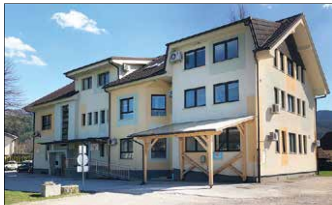
Javni zavod Zgornjesavinjski zdravstveni dom Nazarje bo za izdelavo projektne dokumentacije za projekt obnove obstoječega objekta in gradnjo prizidka k zdravstveni postaji objavil novo javno naročilo z najvišjo dopustno ceno 130 tisoč evrov. (Foto: Štefka Sem)
