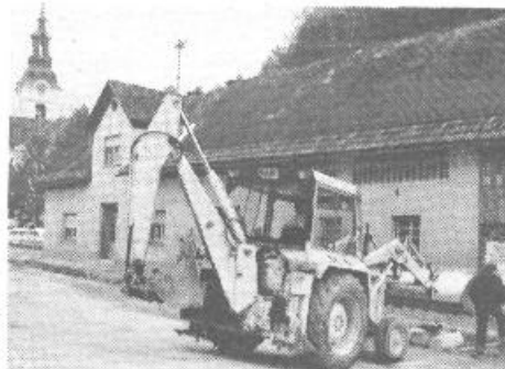
Nadaljevanje gradnje kanalizacije
