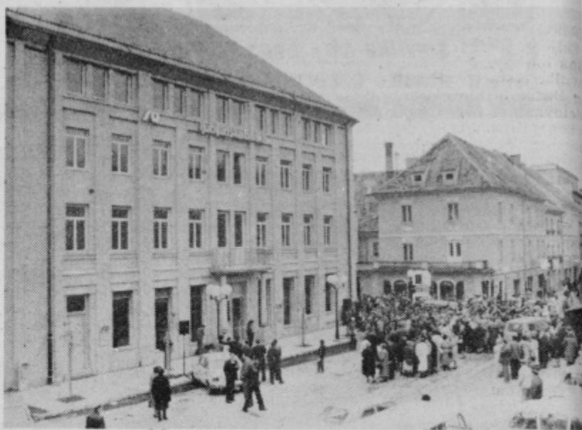
Na Trgu V. kongresa v Celju je zrasla nova bančna stavba z novo ekspozituro LB Splošne banke Celje, ki bo bistveno pripomogla k razbremenitvi ostale enote LB v središču mesta.
