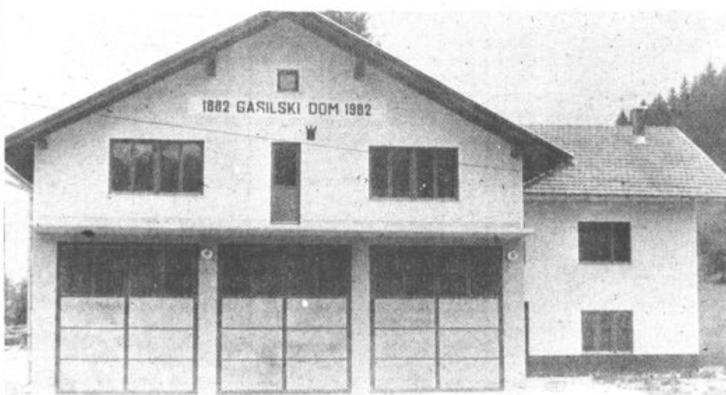
Gasilci iz Grušovlj pridno obnavljajo svoj dom
