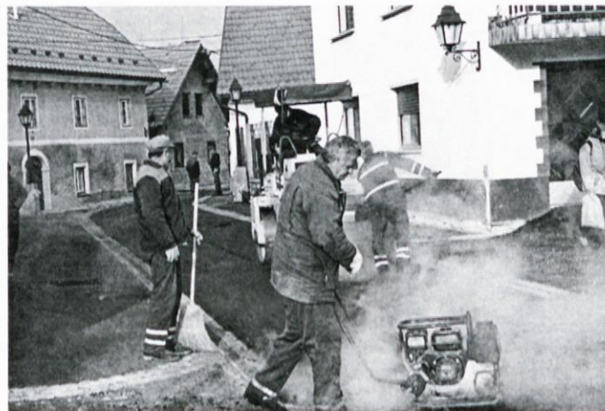
Konec novembra so delavci zaključili dela na Cankarjevi.
