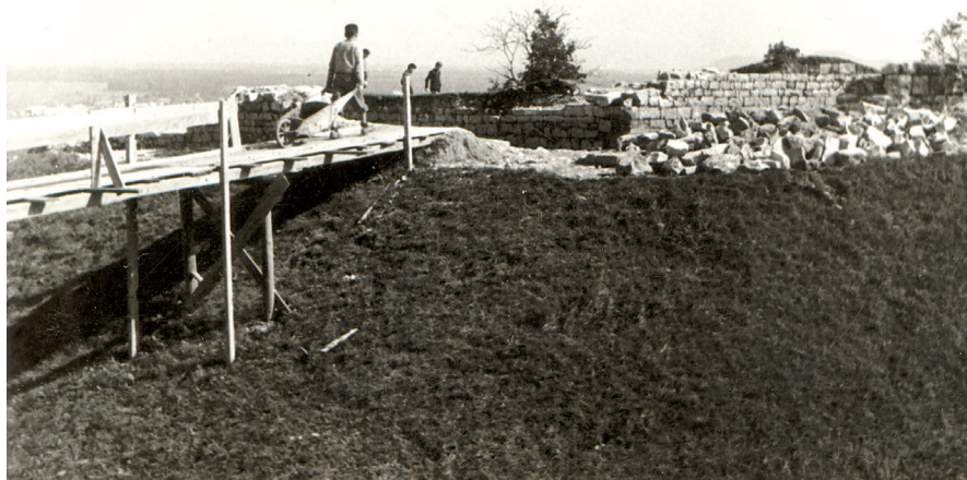
Izkopano zidovje stolpastega gradu z obzidjem, Krancelj, fotografirano 9. 10. 1954.
