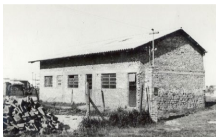
Stavba v l. 1961, sedanja dvorana.
