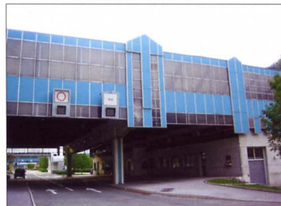
Stavba carine in milice na platoju Karavanke na Hrušici
