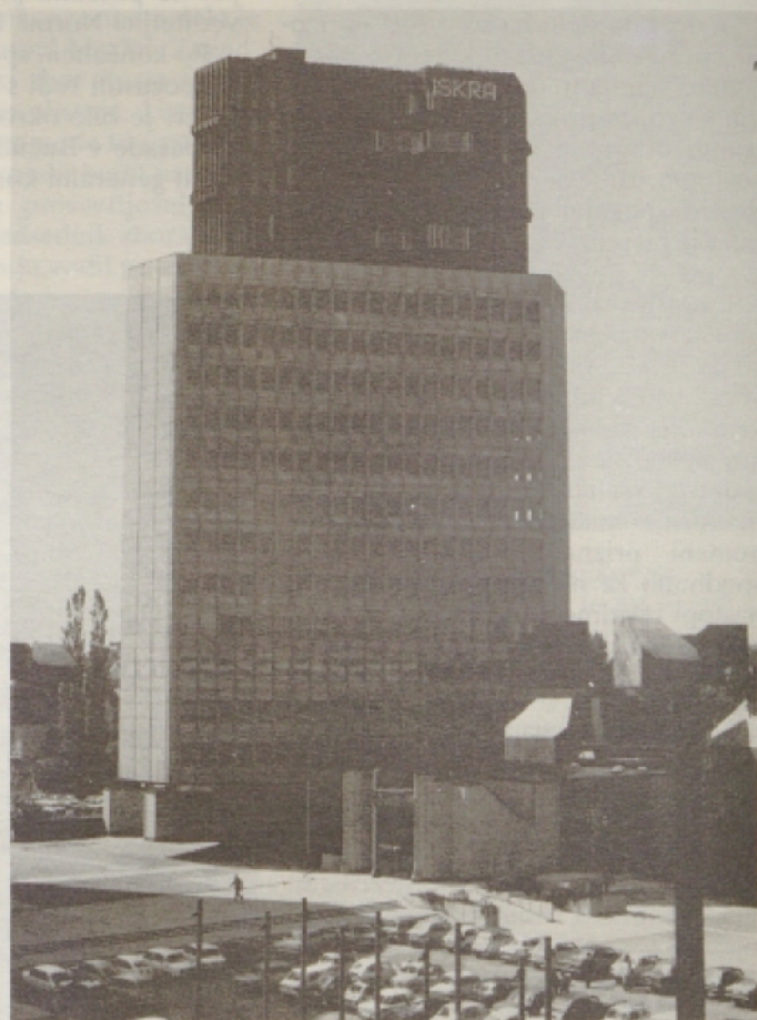
Stavba Iskrinega poslovnega centra v Ljubljani. Iskra headquarters in Ljubljana.
