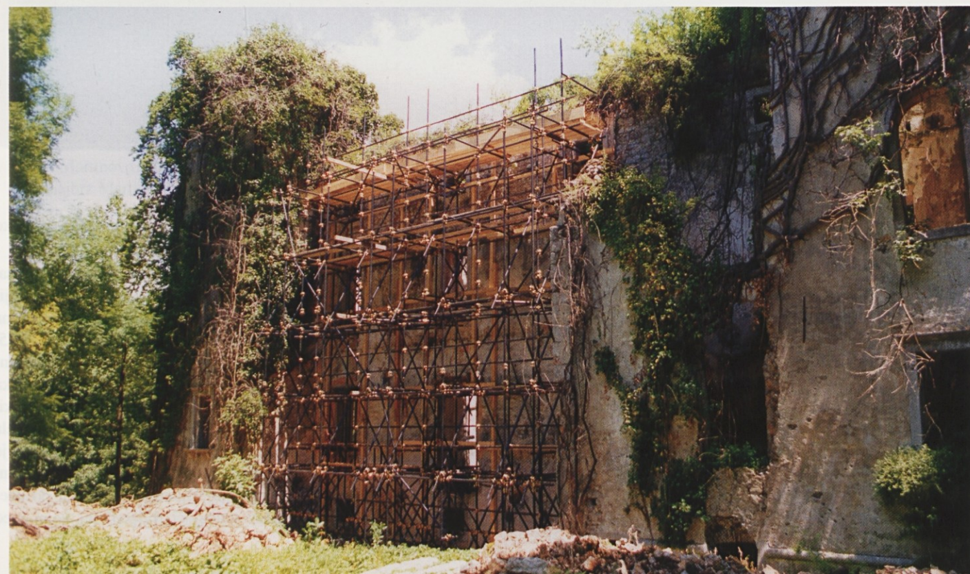
Grajsko poslopje v septembru 1999, obdano z gradbenimi odri.
