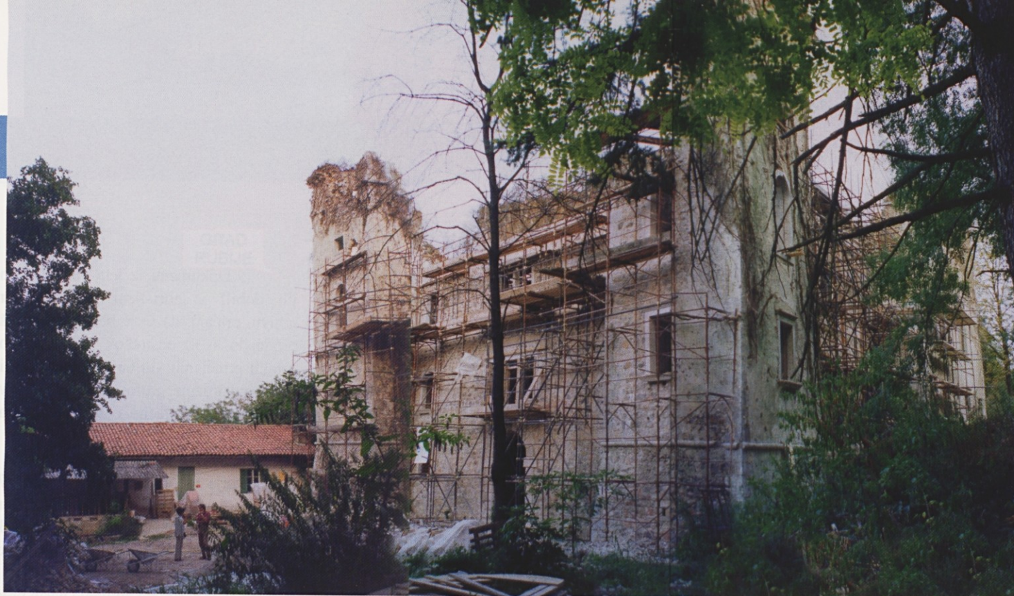
Grajska zahodna (leva) in južna (desna) fasada med prenovitvijo je v letu 2001 že dobivala svojo prvotno podobo... Na levi grajska pristava, v kateri bo po prenovitvi gradu osem apartmajev in grajska recepcija.
