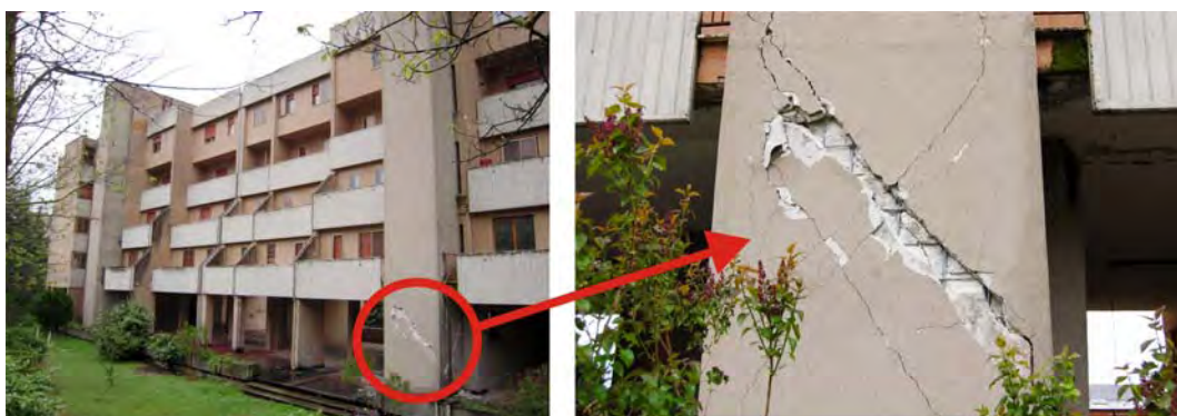
Slika 9.1: Porušitev konstrukcijskih sten med potresom L'Aquila 2009. Foto.: M. Rozman in K. Rejec, 2009
