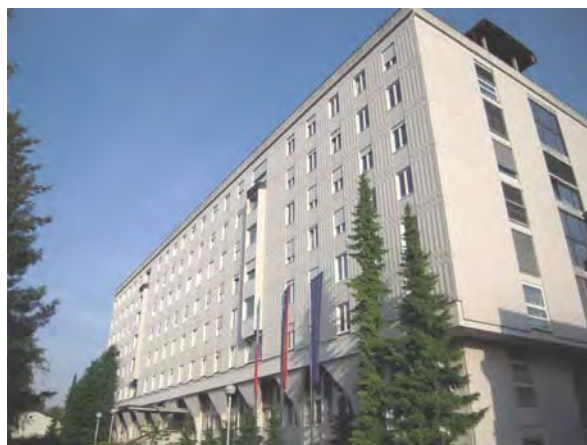
Slika 9.2: Obravnavana obstoječa armiranobetonska stavba
