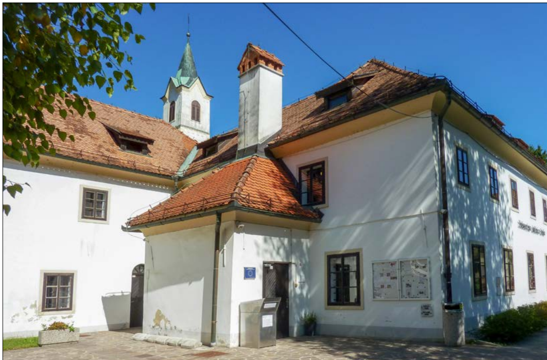
sl. 57 (zgoraj): Izzidana kaminska kuhinja na zahodni fasadi krškega kapucinskega samostana (foto: Tanja Martelanc).
