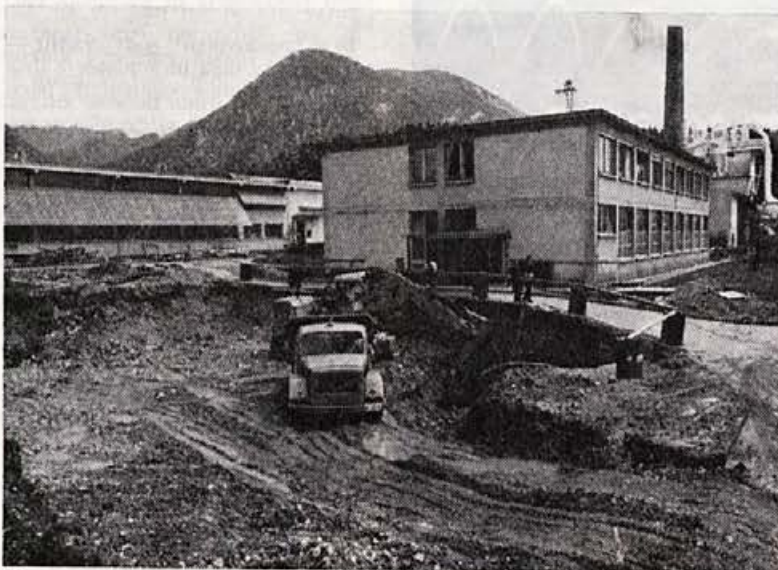
Izkop gradbene jame za novo cisterno pred Institutom, ambulanto in garderobami
