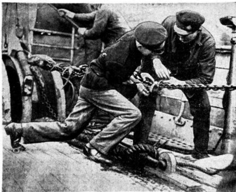
Spušcanje kabla s kabelske ladje
