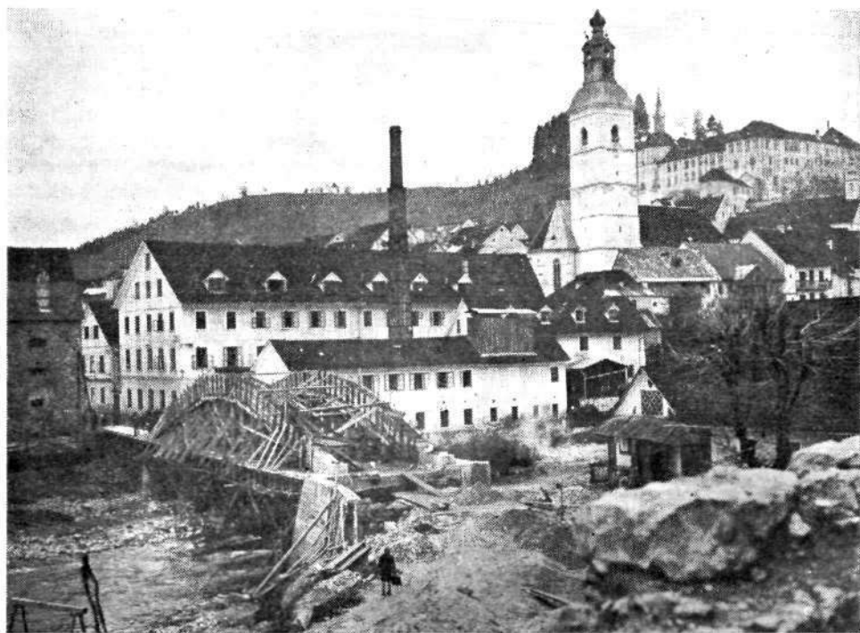
Tovarna Sešir in gradnja Lahovega mostu. (Original podaril Loškemu muzeju Franc Marguč iz Pušala.)
