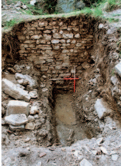
Vzhodna stran. Zid navpičen in prislonjen na osrednji zid kostela / Parte orientale. Muro perpendicolare appoggiato a quello centrale / Istečna strana. Zid okomit i prislonjen na središnji zid kaštela
