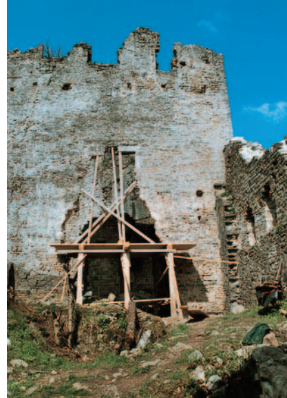
Pogled z vzhoda na osrednji zid po postavitvi odra / Vista da est sul muro principale dopo la costruzione dell'impalcatura / Pogled s istoka na središnji zid nakon postavljanja skele
