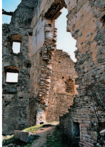
Pogled z zahoda na osrednji zid pred postavitvijo odra / Vista da ovest sul muro principale prima la costruzione dell'impalcatura / Pogled sa zapadne strane na središnji zid prije postavljanja skele
