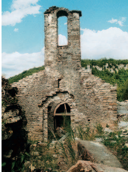
Fotografija cerkvice pred sanacijo / Foto della chiesa prima del risanamento / Fotografija crkvice prije sanacije
