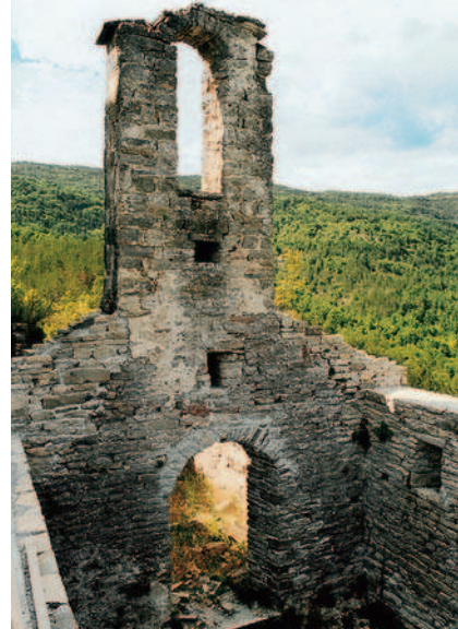
Cerkvica ob začetku sanacijskih del / La chiesetta agli inizi dei lavori di restauro / Crkvica na početku sanacijskih radova
