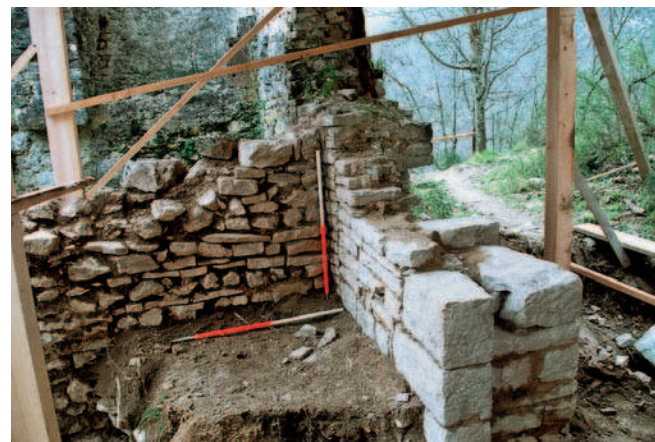
Vzhodna stran. Pogled na vhod / Parte orientale. Vista sull'entrata / Istečna strana. Pogled na ulaz
