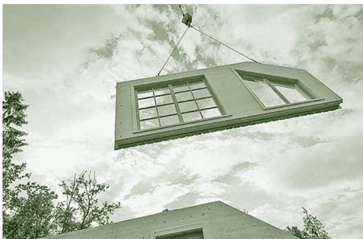
Slika 2: Gradnja montažne hiše
