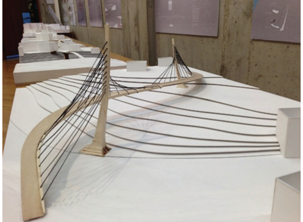
Koncept 3 – viseči most z ukrivljeno osjo in z dvema pilonoma (»landmark« - poudarek v prostoru, dražja izvedba)
