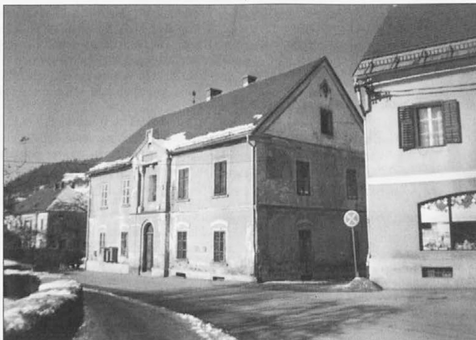
Podoba Fare izpred nekaj let, pred obnovo stavbe nekdanje uprave Mohorjeve družbe
