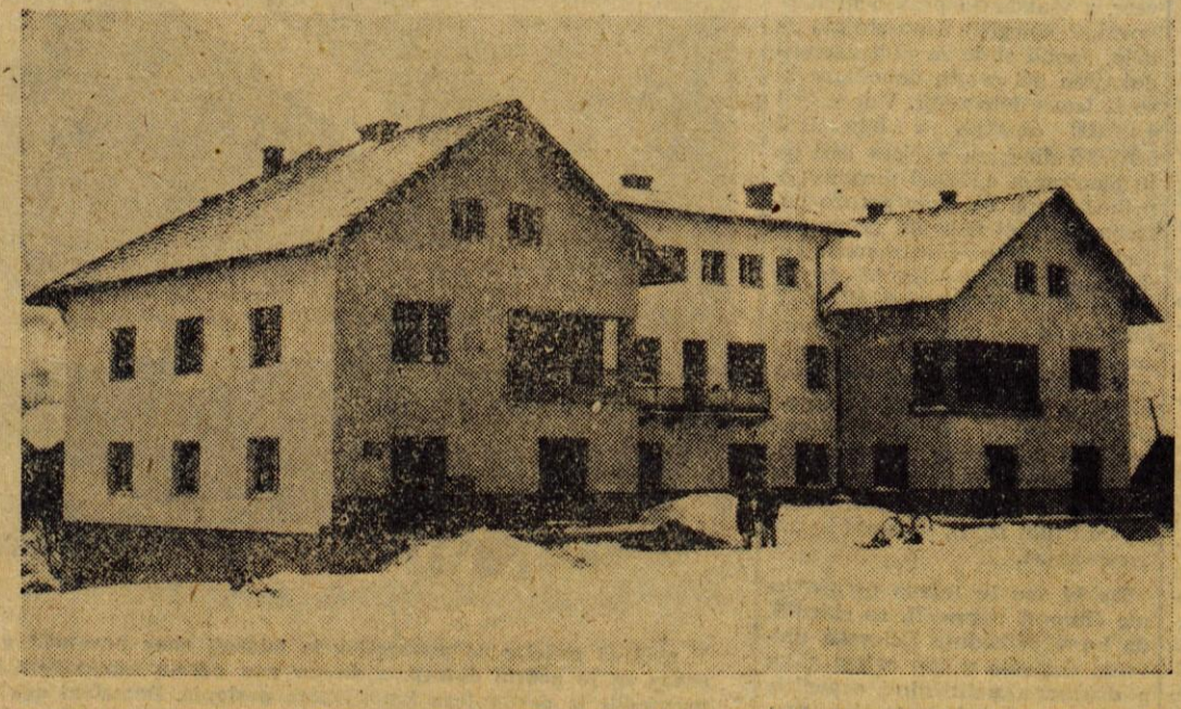
V dokončno urejenem združnem domu v Gorenji vasi (na sliki) bodo v kratkem odprli novo krajevno lekarno. Prostor zanjo je že urejen (v desnem traktu doma), čakajo le še na inventar
