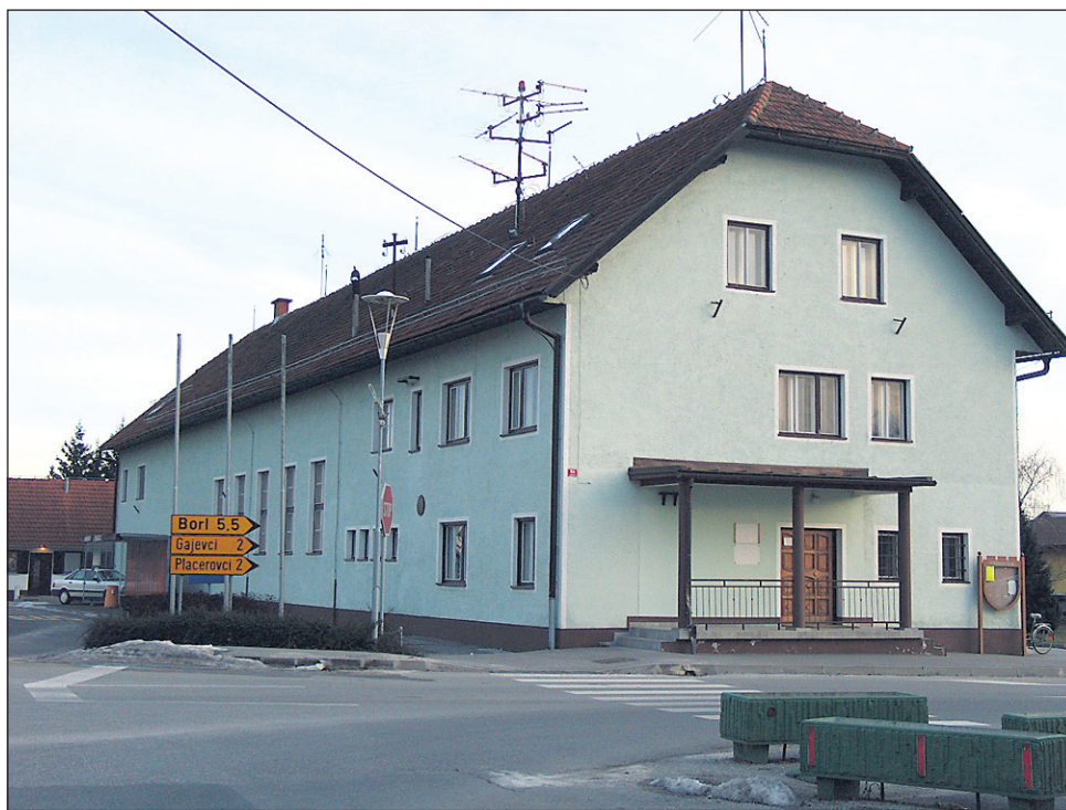
Rušenje zapuščene občinske stavbe s kulturno dvorano je praktično le še vprašanje časa ...
