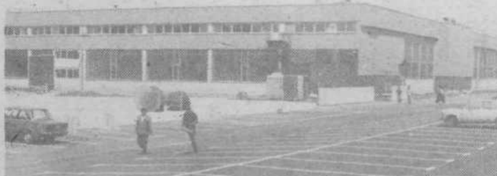
Nova Gradisova tovarna gradbene opreme in strojev ob Letališki cesti
