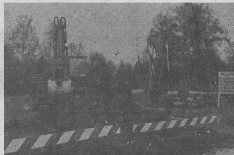
Pršli so delavci s stroji in zasadili prvo lopato (v resnici zajemalko bagra) v zemljo za Moderno galerijo. Torej se je začelo... (foto A. S.)
