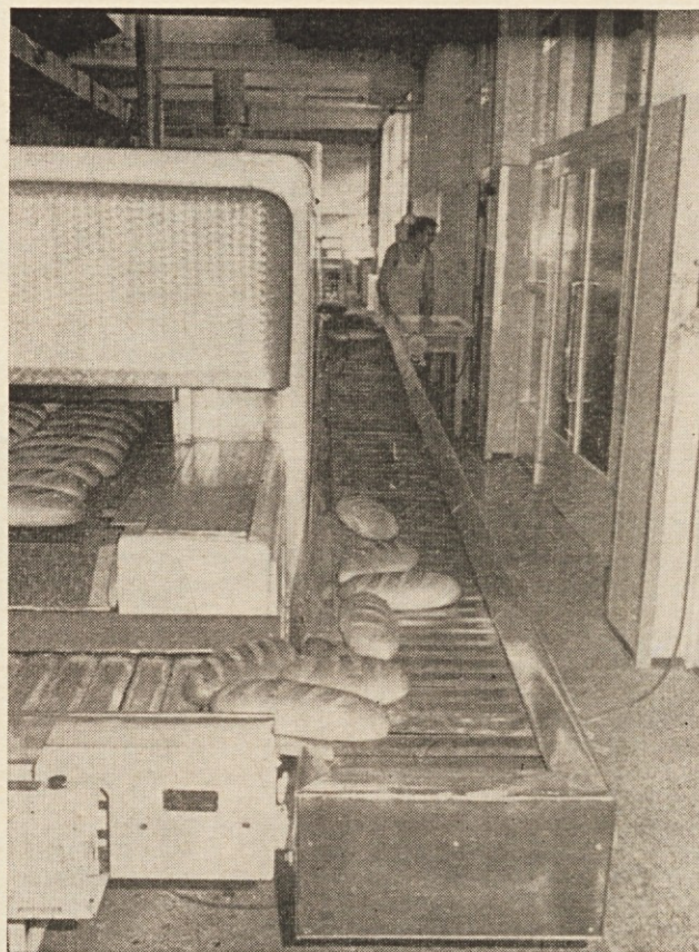
Spodaj: Pogled na delilni in okrogli oblikovalni stroj, ki ga upravlja en človek
