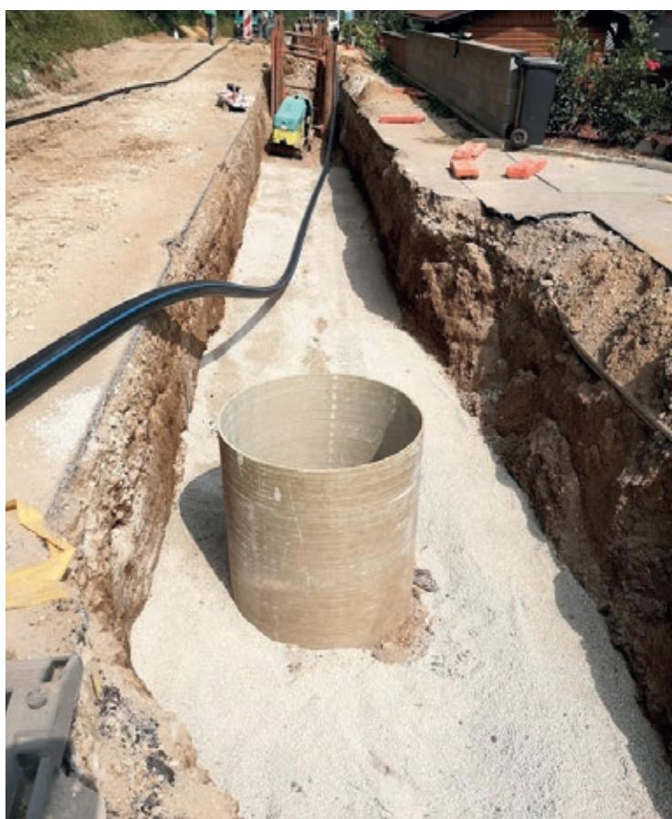
Gradnja kanalizacije v Podkraju je v teku.
