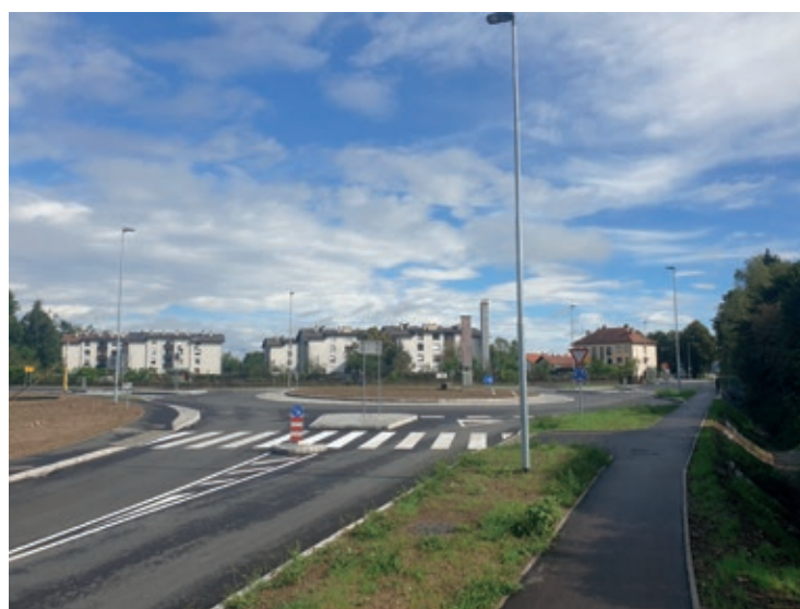
Pogled na novo krožišče KPD na Igu
