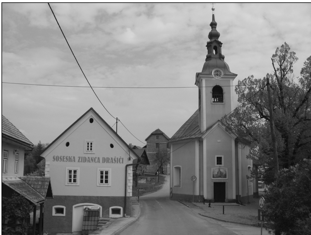
Stavba soseske zidanice in podružnična cerkev sv. Petra v Drašičih (foto: A. Dular, 2010).
