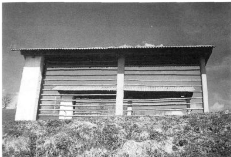
DVOJNI STEGNJENI KOZOLEC »U Kladn'ku« JE BIL ZGRAJEN 1891. LETA. LASTNIK JE PODRL V MESNO POVEZAVO IN DANES STA TO DVA ENOJNA KOZOLCA. LASTNIK: BERNARD ČADEŽ, LEDINE 25 FOTO: TINA MAKUC
