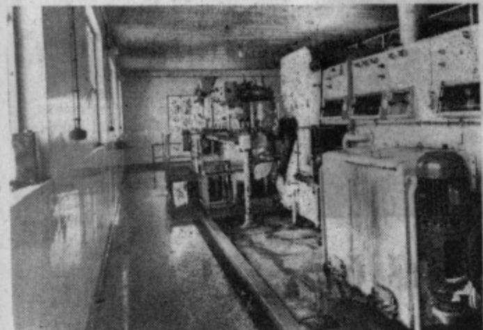
Stroj za polnjenje steklenic lahko v eni uri avtomatsko napolni in zamaši 8000 steklenic
