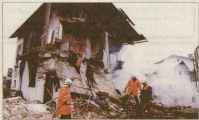
Dan je prinesel grozovit prizor: zadnji del Erhatičeve hiše je dobesedno razneslo.
