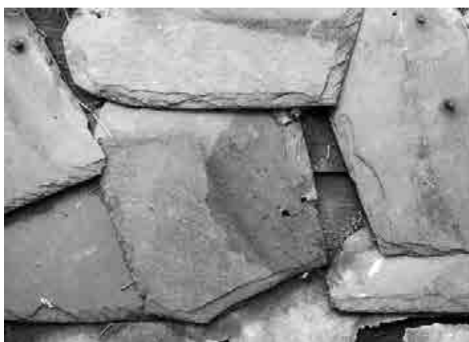
Kritina je iz rdečega skrila, pribitega na podeskanje, kleparski detajli so iz tanke pločevine.
