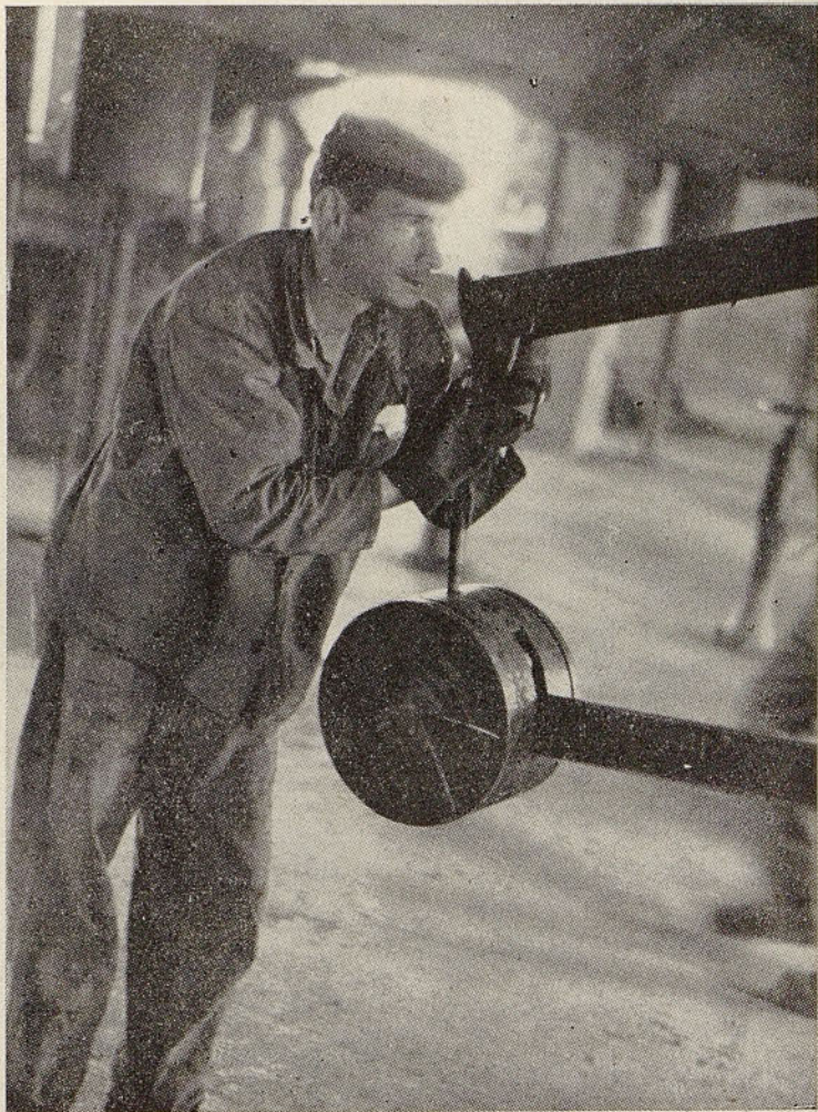
Martin Godec upravlja plinski generator
