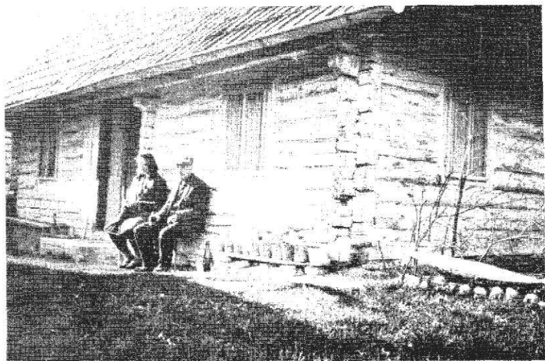
Koča pri Hramovčevi Micki na Brezju pri Moširju. Prvotno je služila kot vinski hram, pozneje pa za stanovanje dninarjem
