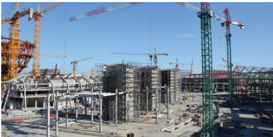
Slika 10 • Gradnja tematskega paviljona.
