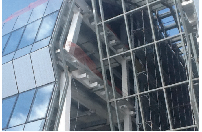
Slika 5 • Konstrukcija in fasadni pas internacionalnega objekta.
