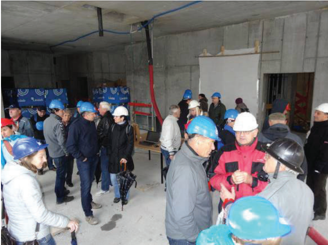
Slika 3 • Na gradbišču Hotela Intercontinental, LJ.
