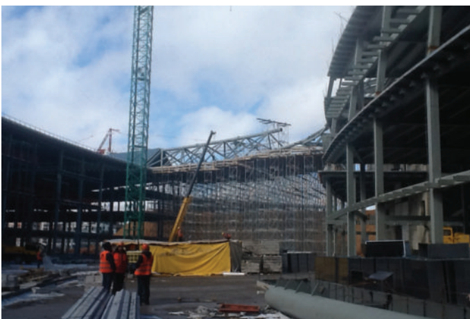
Slika 8 • Montaža enega od strešnih mostov.
