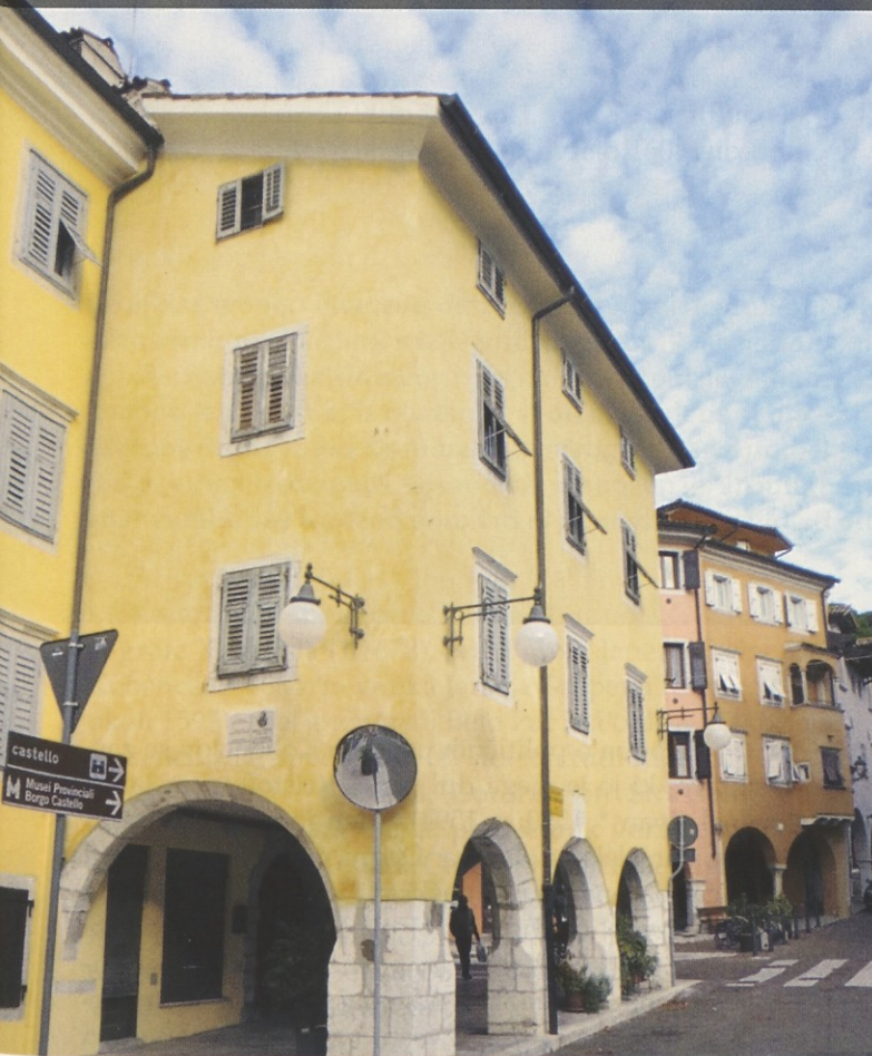
Eckova hiša v Gorici s Trubarjevo spominsko ploščo na pročelju.
