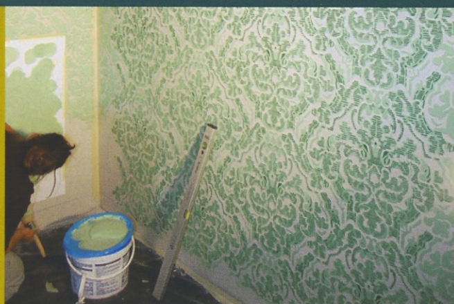
Nanašanje vzorca na stene z matrico. Fotografija: Eda Belingar, 2011.
