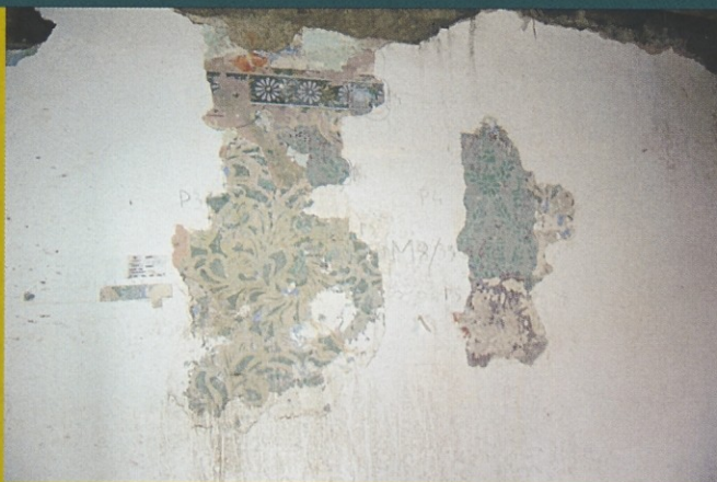
Sondaže sten ene izmed sob v nadstropju, sedaj Ankičine sobe, pred pričetkom gradbenih del. Fotografija: Eda Belingar (2010).
