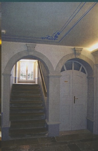
Vhodna veža po končanju del. Za dva sklepnika nad portaloma notranjega kamnitega stopnišča v pritličju so restavratorji izdelali kalup in po njem naredili odlitka ter ju namestili na prvotno mesto. V originalu sta bila narejena iz štukature.
