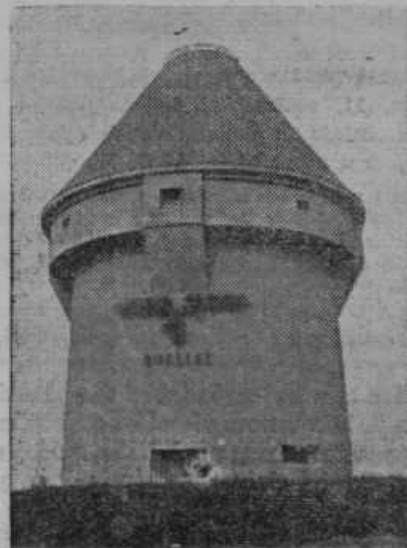
Z neprestreljivimi jeklenimi ploščami obdani stolp v nemški Siegfriedovi obrambni črti na zapadnem bojišču, ki tvori zatočišče za 2000 oseb
