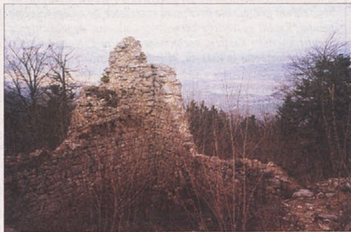
GRAD FRIDRIHŠTAJN - Arhitektura gradu Fridrihštajn je v dolenjskem spomeniškem gradivu izjema. Potegnjeni grajski tloris je značilen za srednjeevropske gradove 14. stoletja. Tak tip gradu se najpogostejše pojavlja na Stajerskem. V grajskem jedru je še mogoče opaziti ostanke dveh palacijev in obzidja ter temelje pomožnih objektov, ohranjena pa je tudi obzidana pot skozi renesančni vhod v zunanjem obzidju. (M. L. S.)
