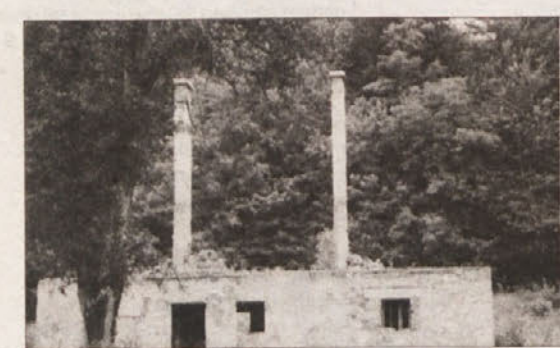
TEŽKO ČAKAJO NA DOM NA FRATI - V zadnjih poletnih dnevih je dom na Frati že precej v drugačnem stanju, kot je bil pred časom, ko ga je uničil požar, kar je dobro razvidno tudi iz priloženih fotografij. Lastnik Ludvik Legan je v obnovi v zadnjem letu vložil že kar lep kup denarja, med drugim pa je ohranil nekaj starih zidov in spominsko ploščo, gostje pa si bodo na fasadi lahko ogledali podobo nekdanjega doma na Frati. Obiskovalci vedno znova sprašujejo, kdaj bo dom odprt. Lastnik upa, da se bo to zgodilo še pred novim letom, ko naj bi začel obratovati spodnji, gostinski del. Zgoraj namerava kmalu zatem urediti še sobe in skupna ležišča. Upa, da z obiskom ne bo težav, saj povpraševanja že zdaj ne manjka. Ob sobotah in nedeljah je obiskovalcev toliko, da se Ludvik pred vprašujočimi pogledi raje umakne, saj jim ne more še nič ponuditi. (Foto: J. D., B. D. G.)
